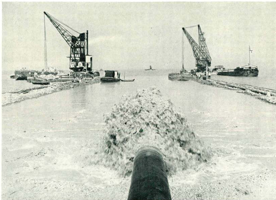
Foto 17. Dijkbouw perceel S. Het opspuiten van het zandlichaam met behulp van een bakkenzuiger. Links en rechts worden met de twee kranen de keileemdammen opgebouwd. Op de achtergrond is de baggermolen, waarmee de slappe lagen onder de dijk worden verwijderd, zichtbaar. (Eigen opnamen)
